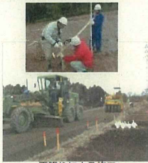
丁張りによる施工
