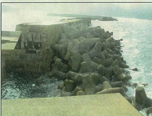
平成17年9月6日 14号台風により被災した防波堤
