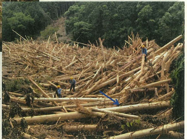
須川第1砂防堰堤 堆砂域に堆積した 流木を撮影
