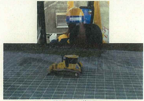
ICT建機による施工
