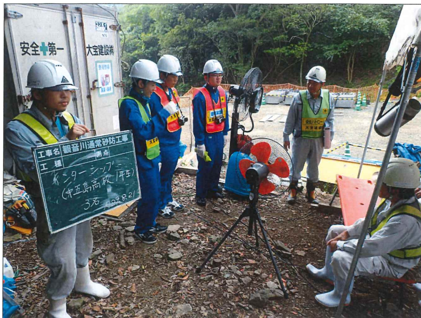
中五島高校インターシップ° 観音川砂防工事にて研修 自己紹介 平成29年8月21日
