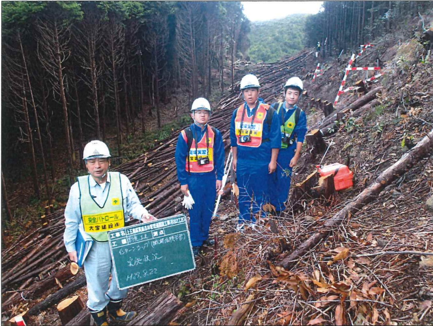
中五島高校インターシップ° 上五島縦貫線林道工事にて研修 柴田社長より工事内容説明 平成29年8月22日
