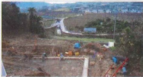
STEP.1 基礎整地
