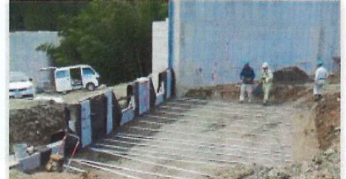
STEP.3 補強材設置
