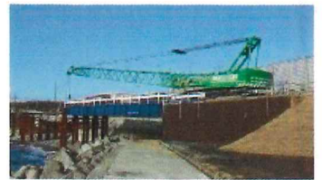
工事用道路・仮設構台
